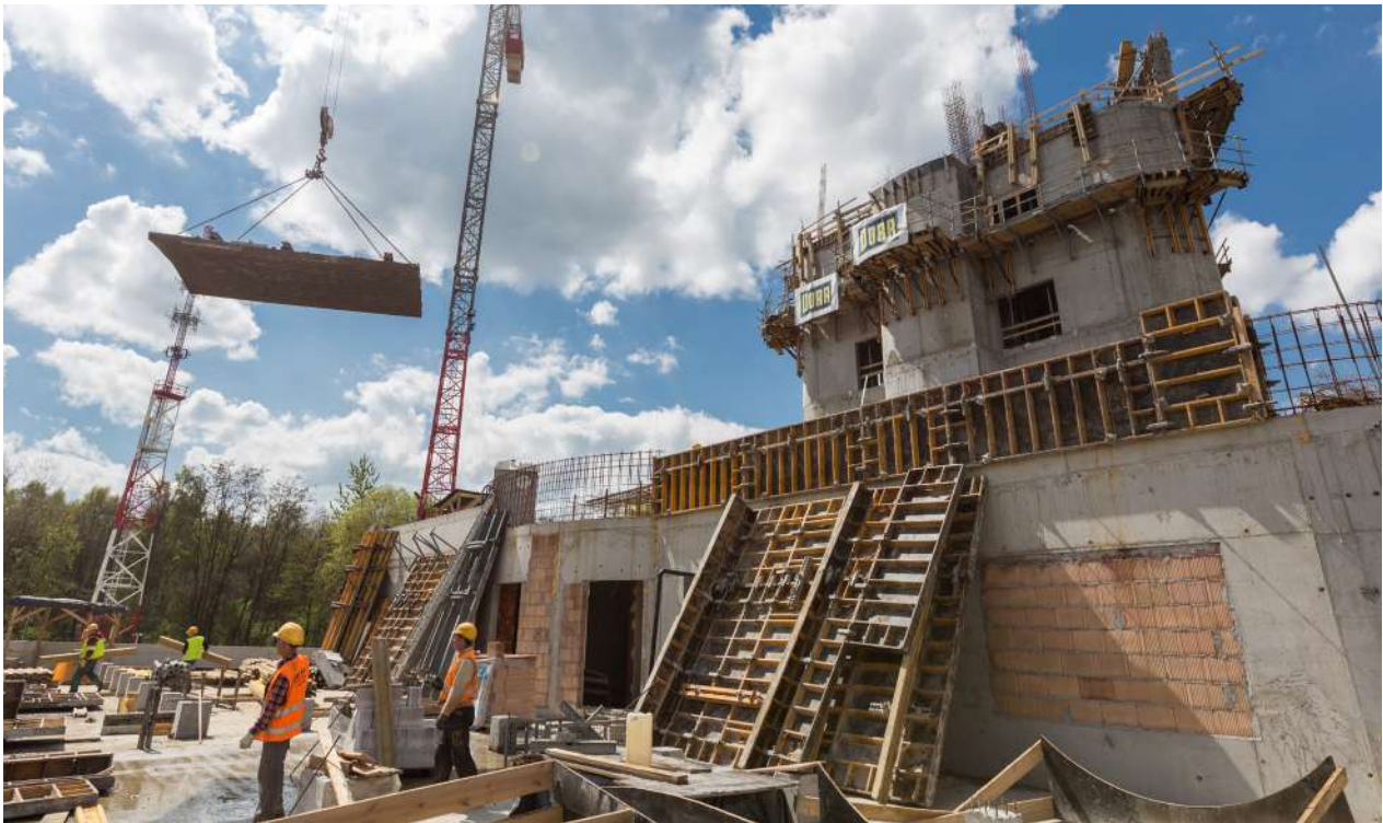
Budowa TWR w Krakowie
